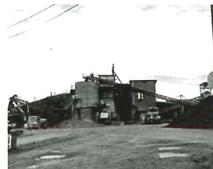
▲エコの時代にふさわしい再生コンクリートプラント
