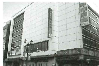
▲新潟で初めて建てられた総合飲食店ビル「クオリスビル」 地下1階 居酒屋 安兵衛 本店 2階 和食ぐるめ 旬月 3階 パーティールーム るんどん亭 4階 四季会席 響香 5階 大広間 信濃川
