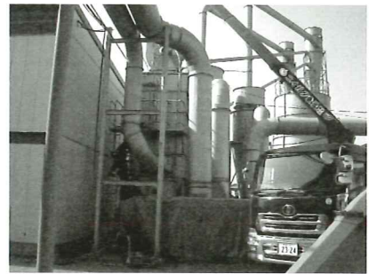
▲大型機械をクレーンで吊上げる
