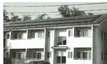
▲太陽光発電システムを設置したアパート「アーバンハギタⅣ」
