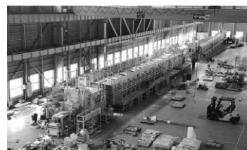
▲設計した工業炉を工場 組み立てている様子
