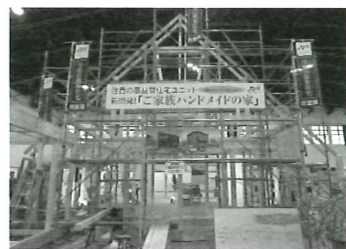
▲組立キットを使えば、素人でも住宅建築が可能(8/23・24 TeNY「住マイルライフ」にて展示)
