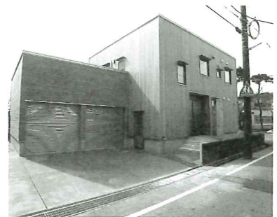
▲雪下ろしがいらぬオリジナル・フラットルーフ（水平屋根）
