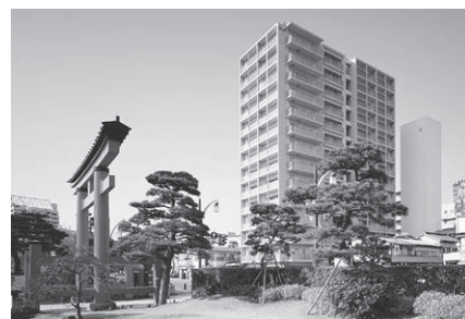
▲同社の施工例（分譲マンション）
