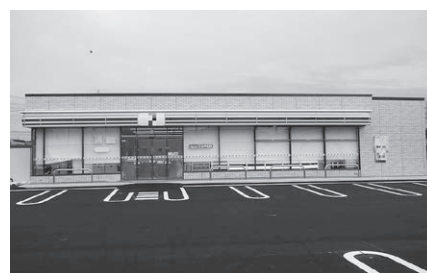
▲同社の施工例（コンビニエンスストア）
