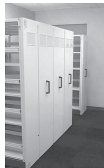
▲弘前大学での施工
