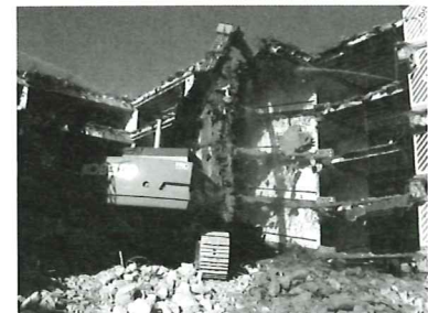
▲低騒音、低振動で解体工事を行う
