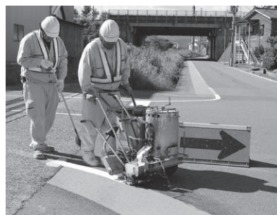
▲道路標示工事の現場の様子
