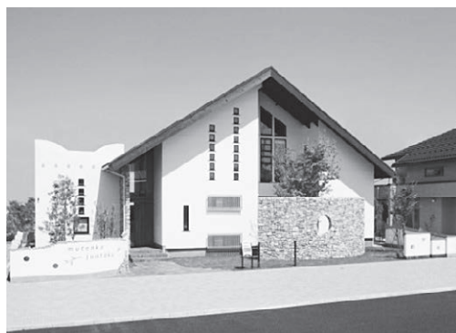
▲施工例（化学物質不使用）
