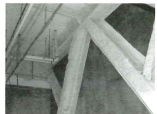
▲施工完了。アスベストを石灰岩化させる
