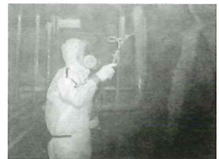
▲アスベストを固化剤で封じ込める
