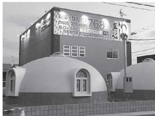
▲本社の横に建てられたドームハウス
