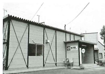
▲同社が手がけた仮設駅舎 (JR上越線塩沢駅)
