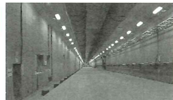
▲平成17年に全線開通した「新潟みなとトンネル」工事
