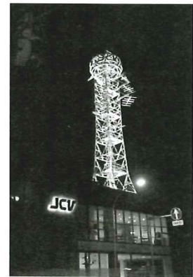
◀ 各家庭のアンテナの代わりに電波を受信する巨大なアンテナ。夜にはライトアップされる
