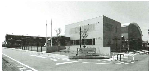
▲長岡市滝谷工業団地にある本社屋及び膜屋根工場
