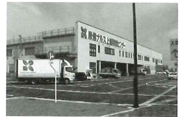
▲新設した上越物流センター
