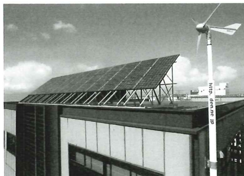
▲同社本社屋上に取り付けた太陽光発電システムと風力発電システム
