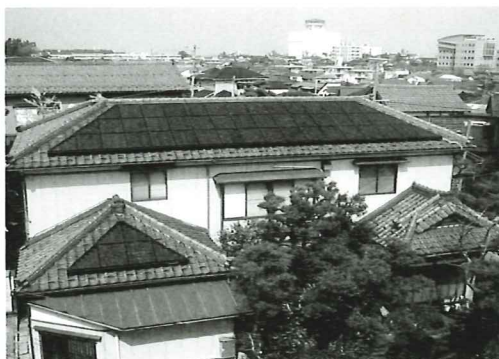
▲住宅に設置した太陽光発電システム
